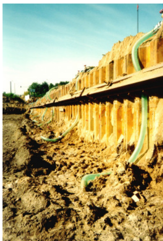
Spundwand mit Saugschlauch der Flächendrainage. Baufeld (rechts).
