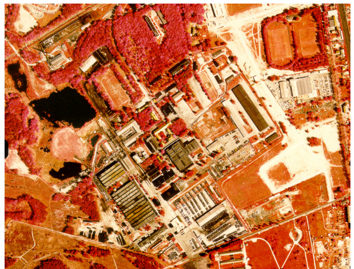
Infrarotluftbild der Liegenschaft vor Abriss und Sanierung der Anlage
